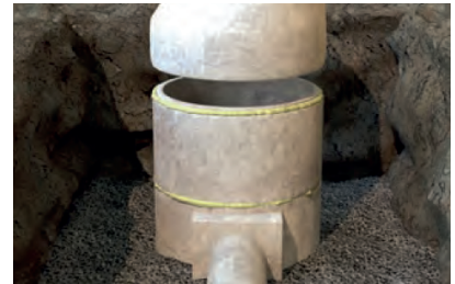
Sellado de anillos de pozos de concreto
